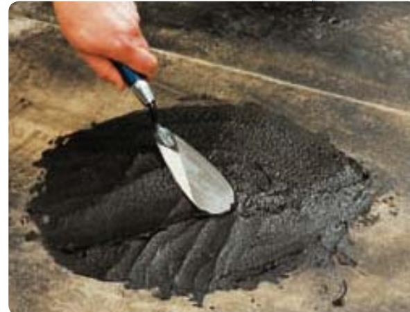
Силно еластична, UV устойчива, еднокомпонентна, битумна ремонтна хидроизолация и битумно лепило. Подсилена с фибри. Съдържа разтворители.
