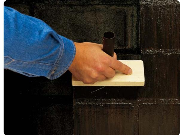
Еластична двукомпонентна битумна хидроизолация без разтворители. За дълготрайна хидроизолация на хоризонтални и вертикални части на сгради.
