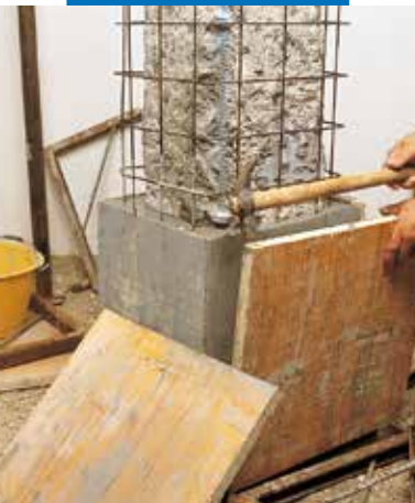
Отстраняване на дървен кофраж
