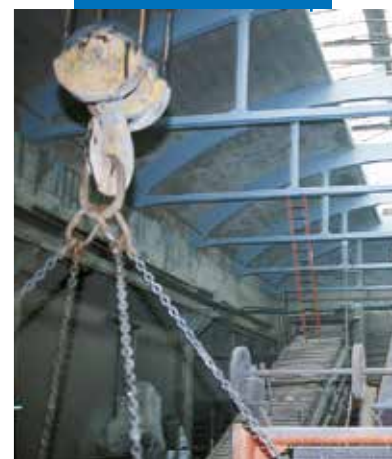
Ремонт на конструкция
