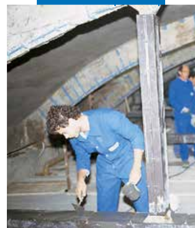
Изливане на Mapegrout Hi-Flow E в метален кофраж
