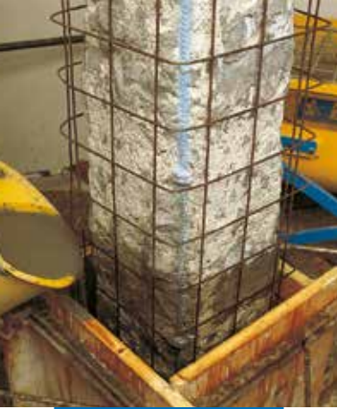
Изливане в кофраж
