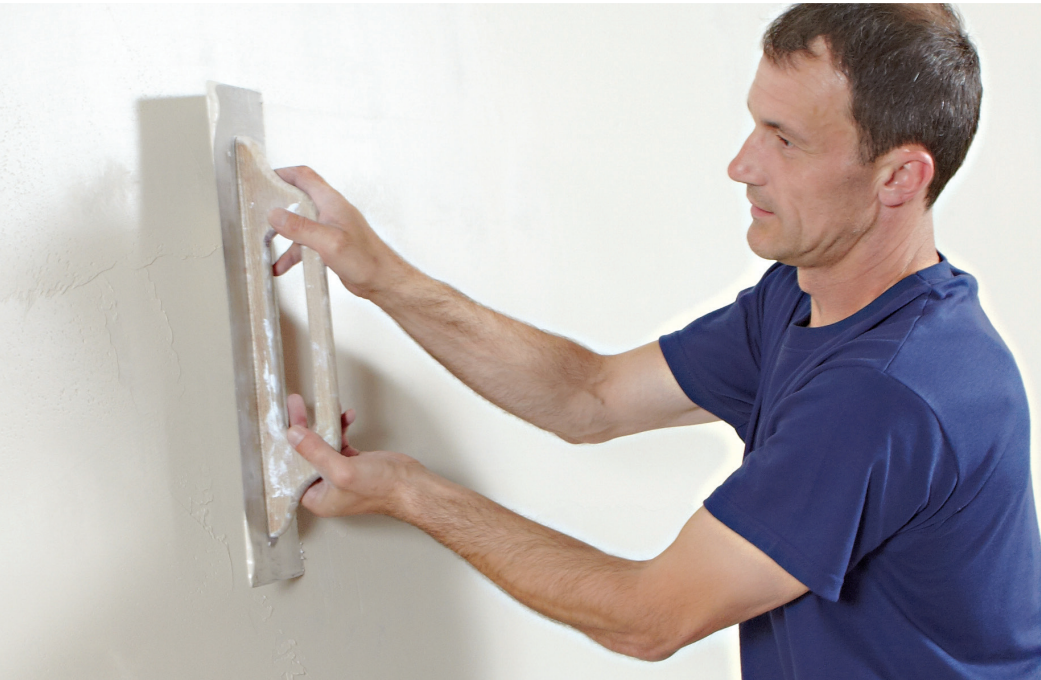
Готова финашна шпакловка и фугопълнител
